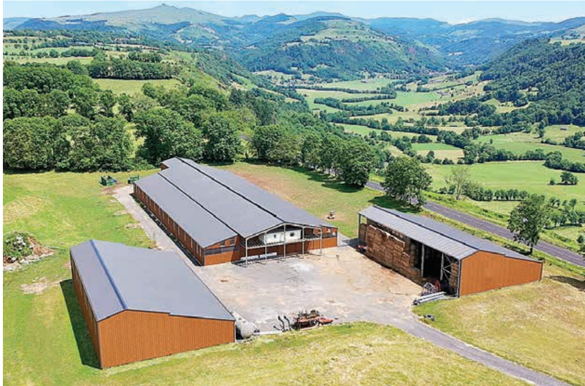
Au lieu-dit "Les Quatre-Routes de Salers", les bâtiments de Denis Magne, montés par la SAS Rigaudière construction, attendent la pose de leurs panneaux solaires.
